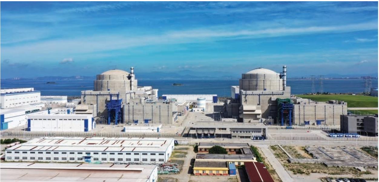
福清核电站5、6号机组（图片：福建福清核电有限公司）
