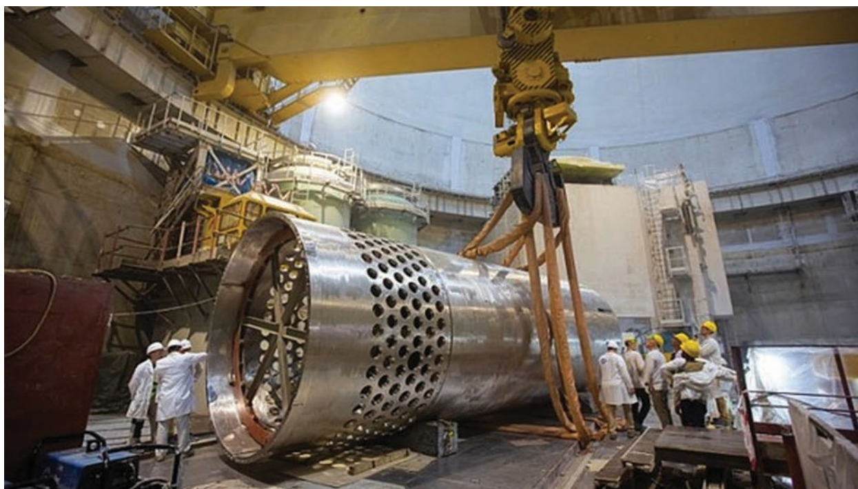
卢普尔核电站1号机组堆芯吊篮的安装工作于2023年5月完成（图片来源：俄罗斯国家原子能公司）
