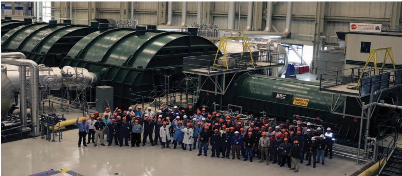
3号机组恢复运行——汽轮机层工作人员照片（图片：安大略电力公司）
