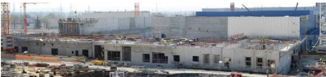
Georges Besse II construction site (April 2007).
