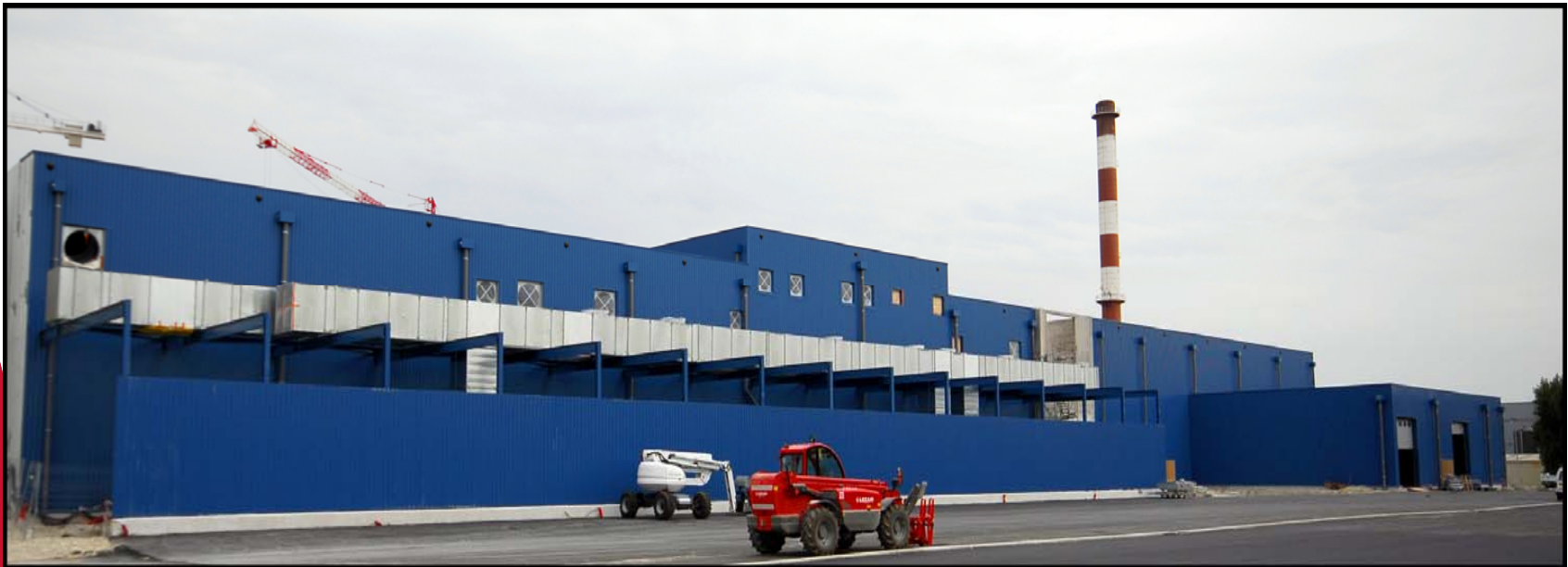
Construction site (August 2007)
