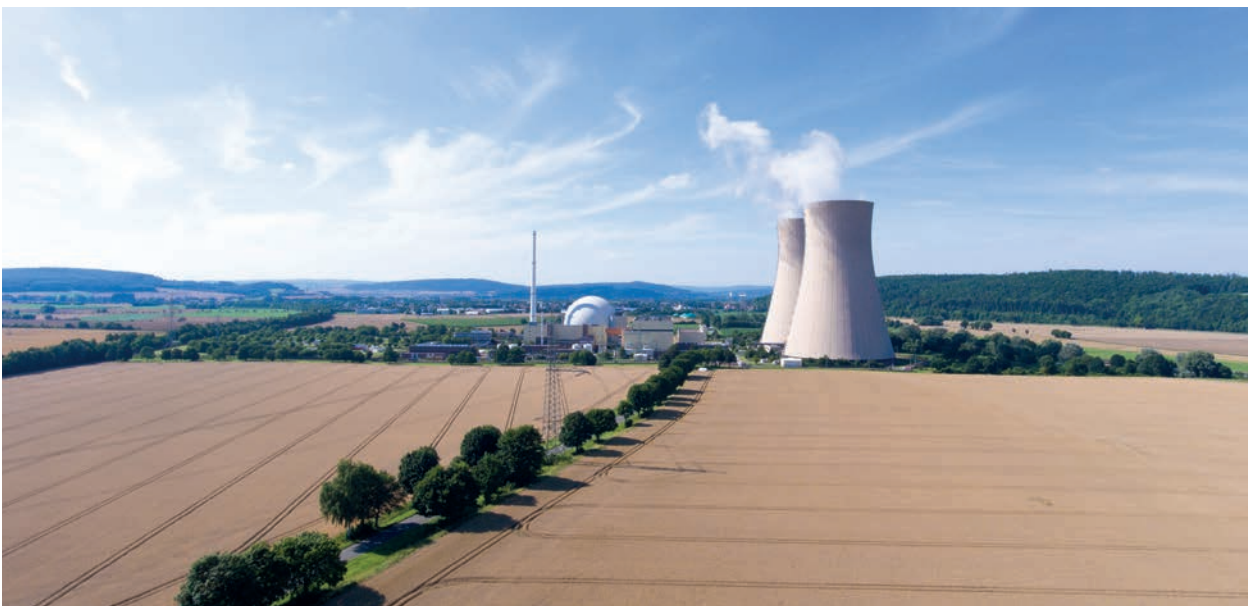
Grohnde NPP (Image: PreussenElektra)
