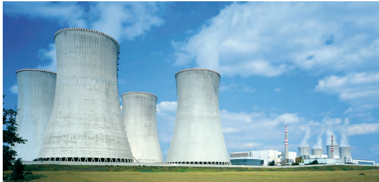
The Dukovany plant (Image: ČEZ, a. s.)
